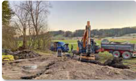
Oben: Erneuerung des Abwasserbehälters der Kleinkläranlage
